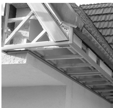
osazené ukonč. profily a první lamela
